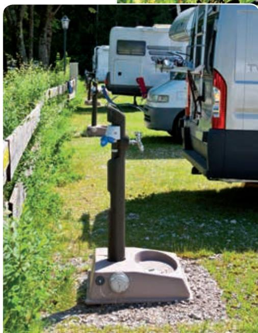
Versorgungssäule mit Strom-, Wasser- und Abwasseranschluss.
